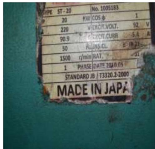
Gambar 7. Generator dan Spesifikasinya
