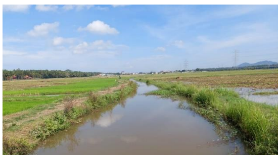
Gambar 13. Kondisi Saluran Drainase Ledeng
