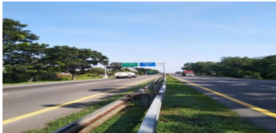
Gambar 5. Fasilitas Pendukung Jalan di Buat Sudah Sangat Jelas Sehingga Mempermudah Pengguna Jalan
