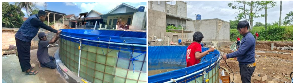
Gambar 10. Dokumentasi Instalasi sistem aerasi pada kolam bioflok
