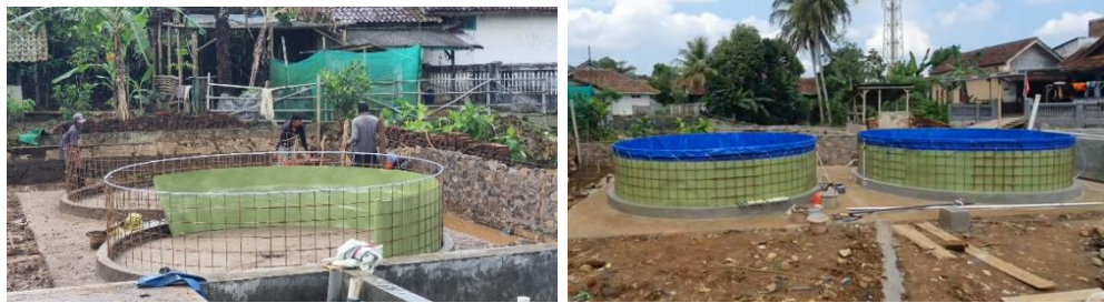
Gambar 9. Dokumentasi perakitan dinding kolam dan terpal
