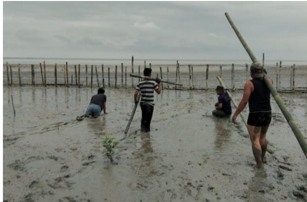
Gambar 3. Kegiatan pembuatan pagar bamboo
