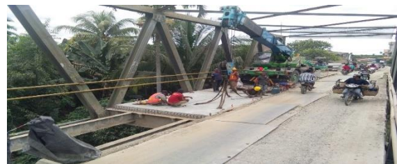
Gambar 6. Pemasangan Double Tee Setengah Bentang
