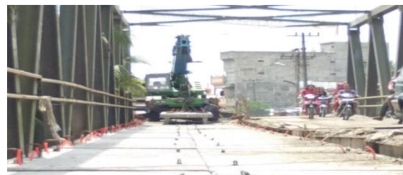
Gambar 7. Double Tee Selesai Dipasang Setengah Bentang
