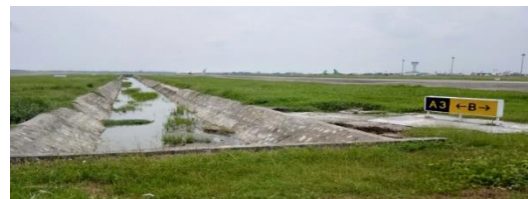
Gambar 4. Saluran eksisting drainase jalur 1
