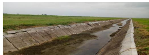
Gambar 5. Saluran eksisting drainase jalur 2
