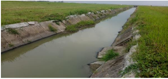
Gambar 6. Saluran eksisting drainase jalur 3
