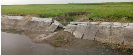
Gambar 7. Saluran eksisting drainase jalur
