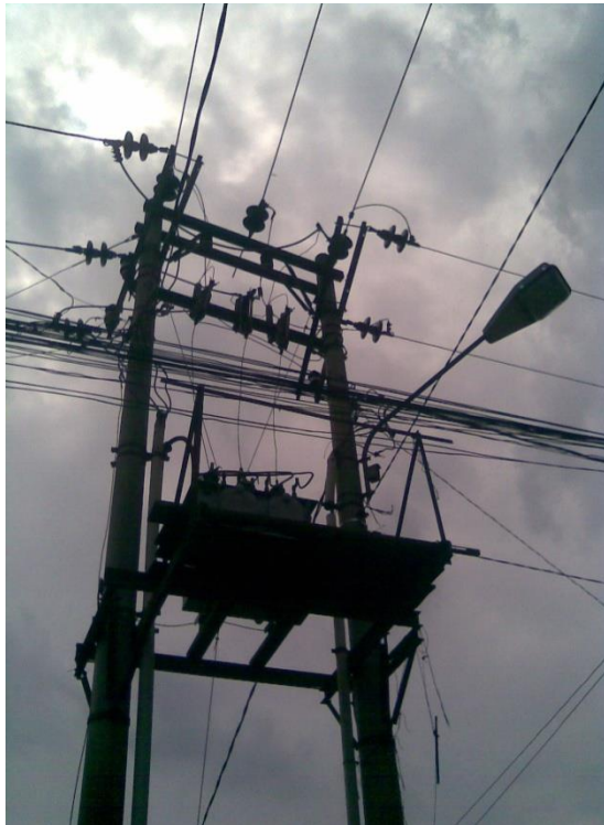
Gambar 2. Transformator distribusi MS 328 Jl. Selamat Ujung Medan
