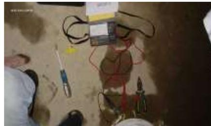
**Gambar 5. Pengukuran tahanan isolasi antara fasa S dengan netral (gruf 3)**
