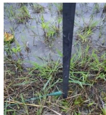
Gambar 2. Elektroda Batang
