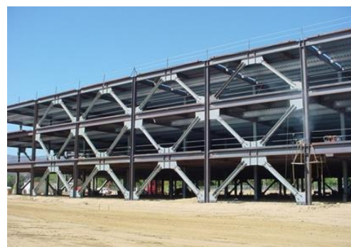
Gambar 12. Sistem Struktur Baja Tahan Gempa CBF Sumber: Bahan Presentasi Program Studi Magister Tek.Sipil USU
