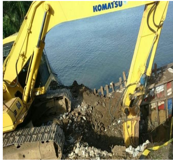
Gambar 3. Pembongkaran beton sayap
