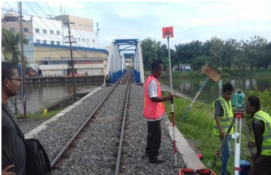
Gambar 2. Pemasangan patok rencana
