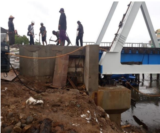
Gambar 7. Pemasangan balok jembatan
