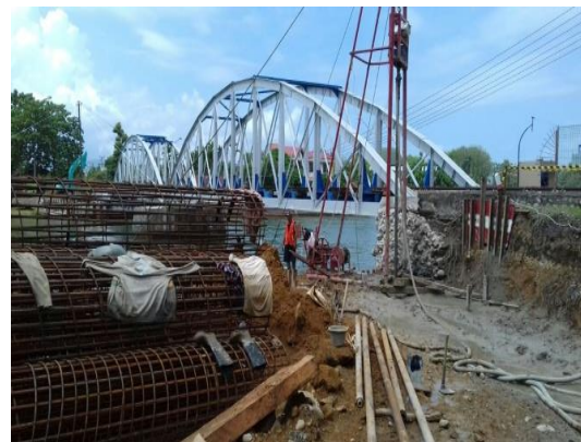
Gambar 5. Pengeboran bore pile
