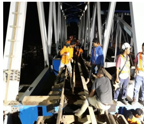
Gambar 9. Penggeseran jembatan baru
