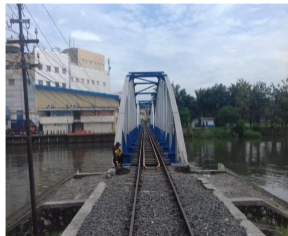
Gambar 1. Kondisi existing jembatan lama
