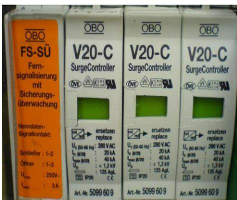
**Gambar 5. Arrester yang digunakan**
