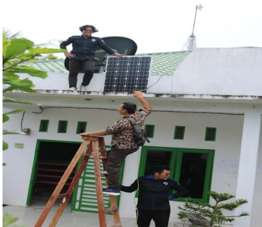
Gambar 12. Pemasangan panel surya di atas atap kantor kepala desa Lubuk Shaban
