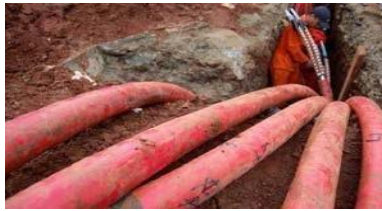
Gambar 4 Kabel Tanah (XLPE)
