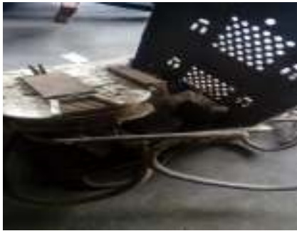
Gambar 6. Limbah trafo yang sudah tidak terpakai
