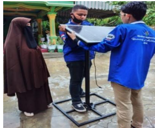
Gambar 2. Peletakan panel surya diatas kerangka atau dudukan panel surya
