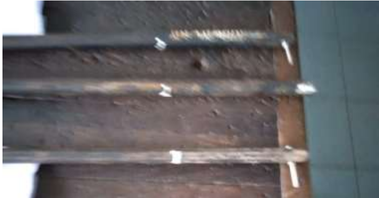
Gambar 8. Terminal ukur sisi kanan
