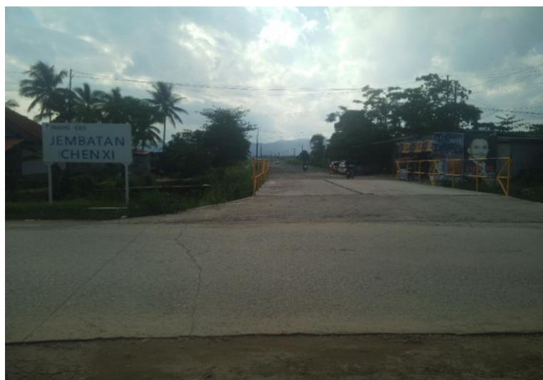
Gambar 3. Jembatan Besi yang dibangun PT. VDNI di Desa Morosi Sumber: Dokumentasi pribadi, 2024
