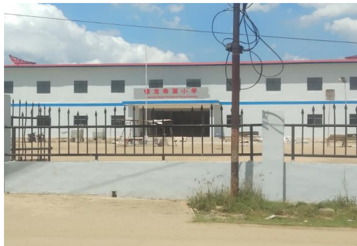
Gambar 5. Sekolah yang dibangun PT VDNI di Desa Morosi Sumber: Data Primer (2024)
