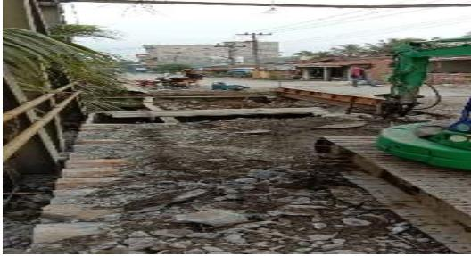
**Gambar 3. Pembongkaran lantai Jembatan**
