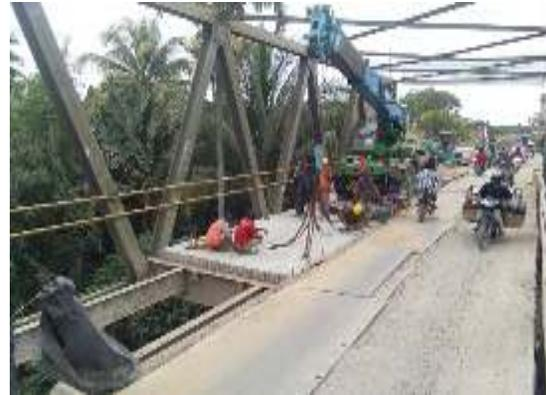
**Gambar 7. Pemasangan Double Tee**
