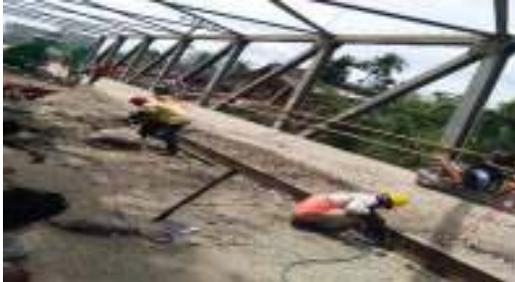
**Gambar 4. Perkuatan Lantai Jembatan yang Dilalui Lalu Lintas**
