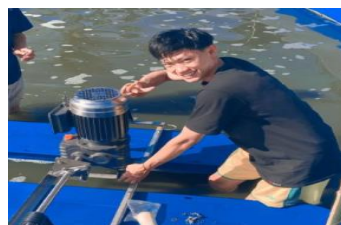
Gambar 2. Pemasangan kincir air
