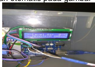
Gambar 4. Keadaan Level Air 0 Dan Mengirim Sms
